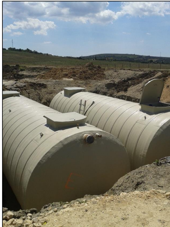
Figura 2: instalación de los reactores SBR durante la etapa de ejecución de la E.D.A.R. i primigenia.
