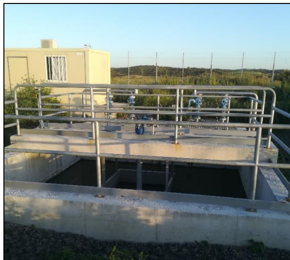
Figura 4: estado final del decantador primario proyectado en la ampliación.
