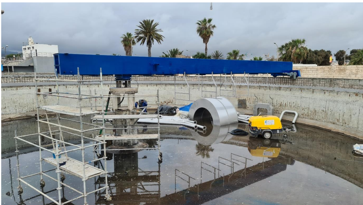
Figura 2: sustitución del equipamiento mecánico del decantador A de la EDAR de melilla
