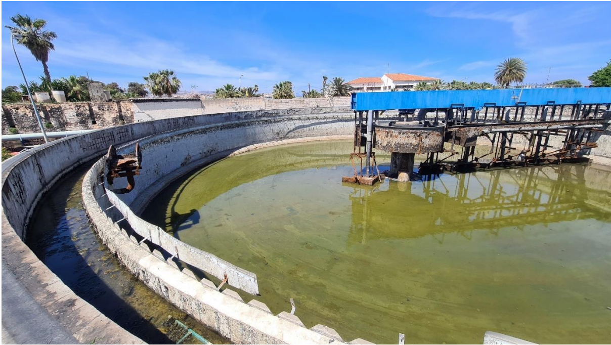
Figura 1: estado inicial de los decantadores A y B de la EDAR de Melilla.
